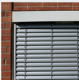
President monterad på utsidan av fönsterkarmen
